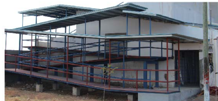
Fase 2: Remodelación del Edificio
