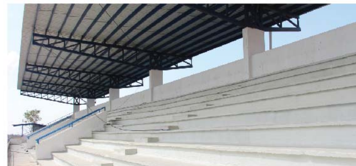
Fase 1: Reparación de techos y graderías
