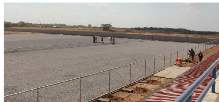
Fase 3: Construcción de la cancha de Grama Sintética
